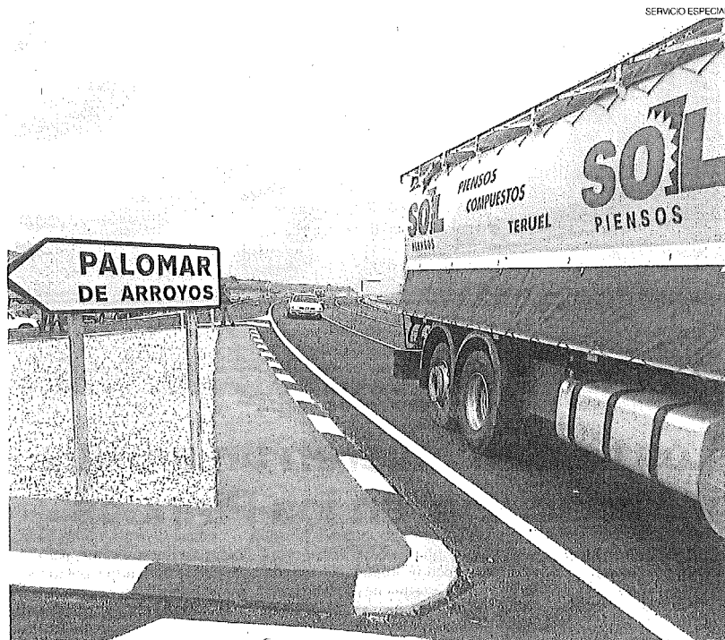
Las carreteras autonómicas conforman una malla que enlaza todas las comarcas aragonesas.
